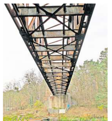
Die Friedhofsbahn-Brücke wird vom 26. bis 29. November abgebaut. FOTO: GEMEINDE STAHNSDORF
